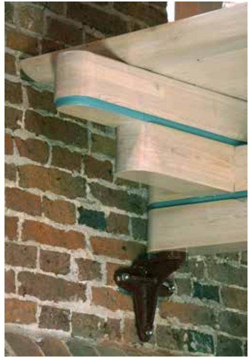
Oplegging balgzolder op stalen ankeras
