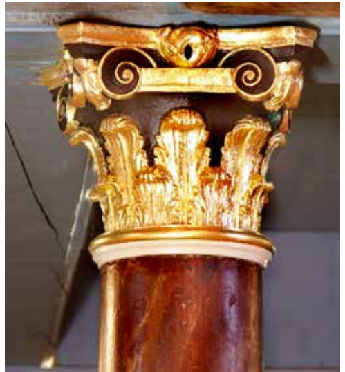
Kolom met Korintisch composietkapiteel als ondersteuning van de voorste dwarsbalk
