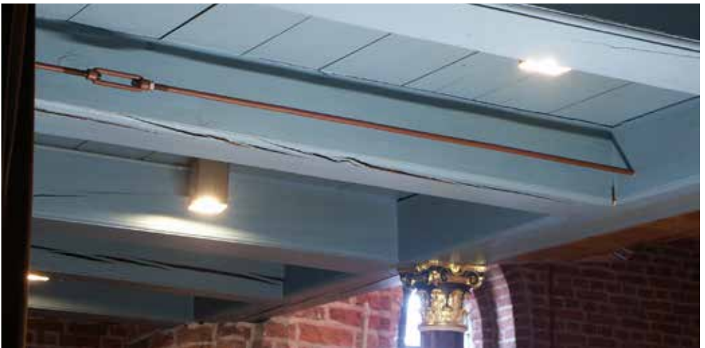
Trekstangverbinding tussen de beide dwarsbalken
