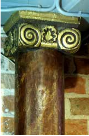
Gemarmeerde kolom met verguld Ionisch kapiteel als ondersteuning van de achterste dwarsbalk
