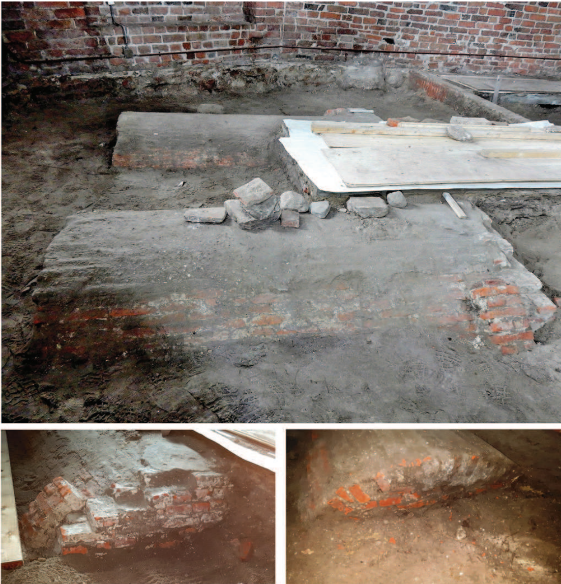
Fig. 12. Boven: de twee bakstenen grafkelders in het oosten van het koor, gefotografeerd vanuit het noorden. Volgens het opschrift op de zerk zijn Coenraad Wolter Ellents en Gesina Oldenhuis in de achterste (zuidelijke) kelder bijgezet. Foto Hidde Boerema. Linksonder: de dichtgemetselde ingang van de noordelijke kelder. Foto F. Bosman. Rechtsonder: de achterzijde van de zuidelijke grafkelder. Foto P. den Hengst.
