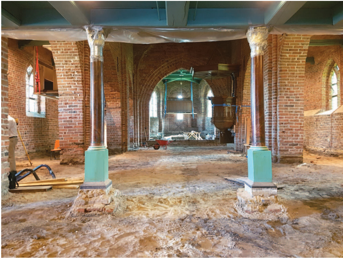
Fig. 1. Interieuroopname van de Catharinakerk nadat de vloer en ongeveer 30 cm zand verwijderd zijn. De meeste archeologische waarnemingen zijn op het niveau van het ontsloten vlak gedaan. In de zijbeuk links en in het koor op de achtergrond zijn de herenbanken in de touwen gehangen om ze tijdens de werkzaamheden te beschermen. De foto is naar het oosten genomen. Foto F. Bosman.
