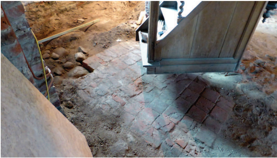
Fig. 7. Resten van de vermoedelijk 13 de -eeuwse vloer van de bakstenen kerk. Het gedeelte vooraan bestaat uit plavuizen, links liggen er bakstenen. Linksboven is de vloer van leem die over de veldkeien was gesmeerd al verwijderd. De foto is in zuidwestelijke richting genomen bij de preekstoel die tegen de meest-zuidoostelijk pijler staat. Foto G. van den Beemt.
